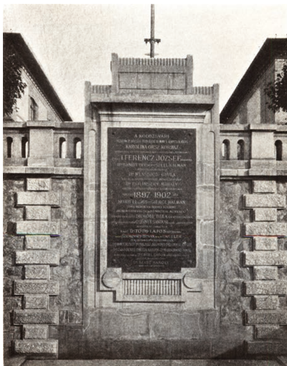
23. kép A klinikatelep építkezési emléktáblája
