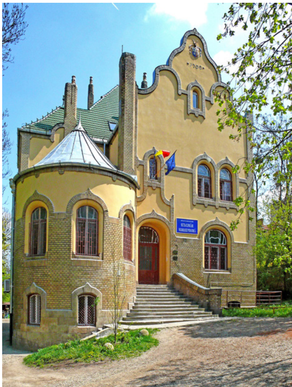
21. Kolozsvár, Lechner-villa III. Magas nyeregtető fedí zöld cserép héjalattal. László Miklós fotója. Forrás: https://www.szecessziomagazin.com/magazin1/kolozsvariszecesszio.php
