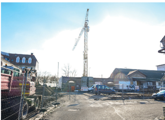
A Sóstó főépületének homlokzatait meghagyják, a melléképítményeket pedig visszabontják, helyükön zöldterületeket, játszótérrel, parkolókat alakítanak ki.
