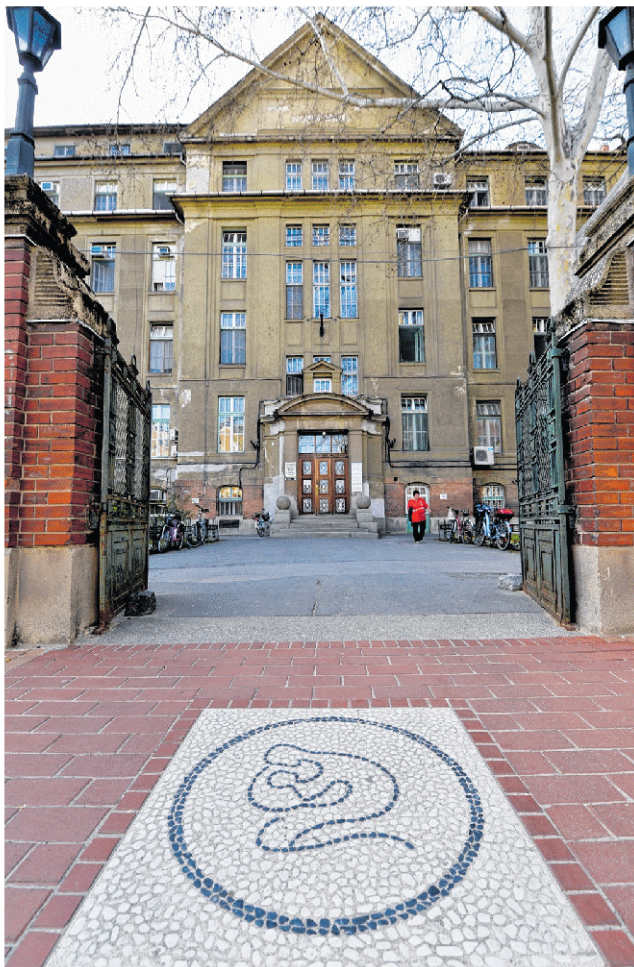
A 90 éves épületre igencsak ráfér a felújítás. FOTÓ: KARNOK CSABA
