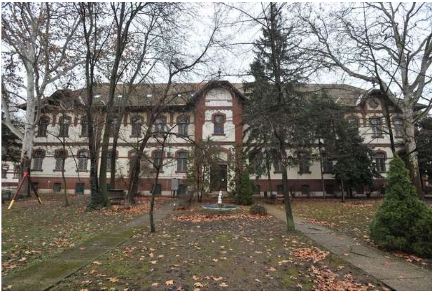
A védett épület megjelenését nem szabad megváltoztatni. Fotó: Karnok Csaba
