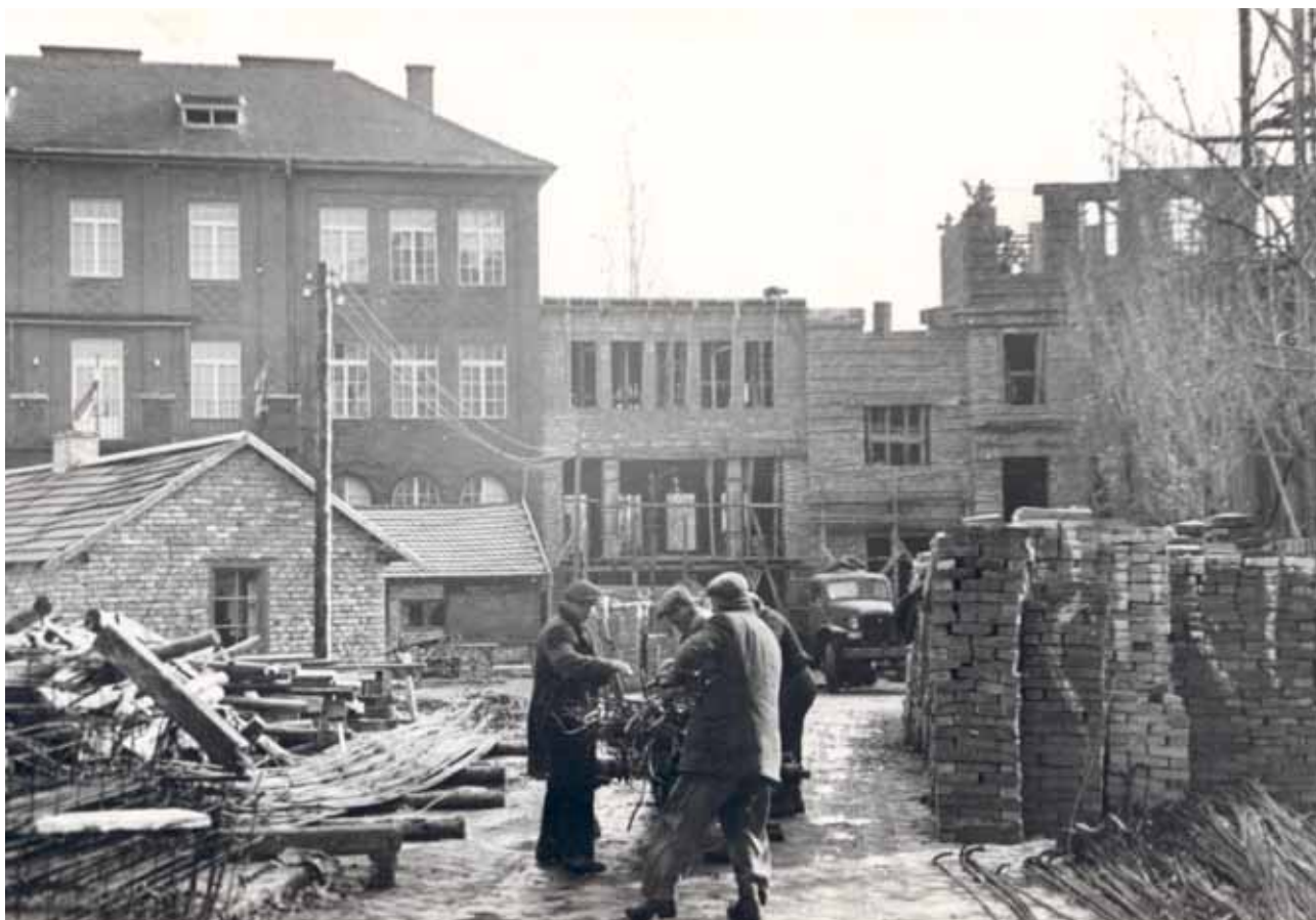
▲ A Béke épület építése 1951-ben
